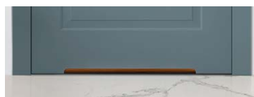
Podcięcie łazienkowe, wys. od podłogi 19 mm
