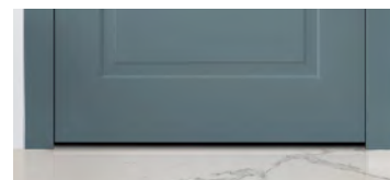
Skrót „rekuperacyjny” (szczelina), wys. od podłogi 14 / 16 mm
